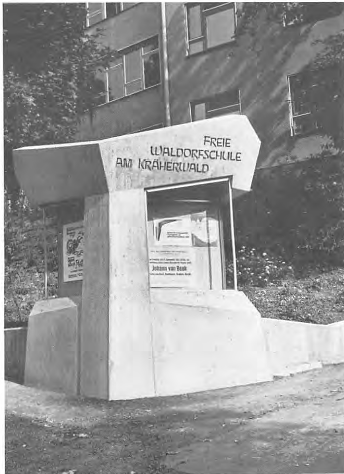
Neuer Aufgang zur Schule
